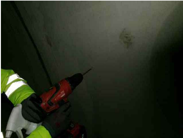
탄산화깊이 측정 현황
