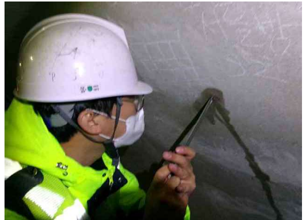
탄산화깊이 측정 현황
