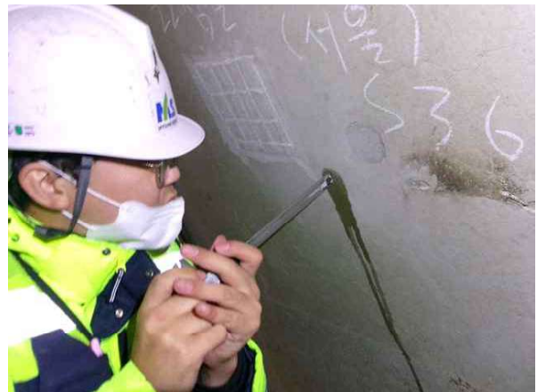
탄산화깊이 측정 현황
