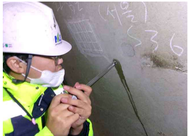
탄산화깊이 측정 현황
