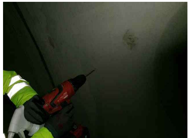
탄산화깊이 측정 현황
