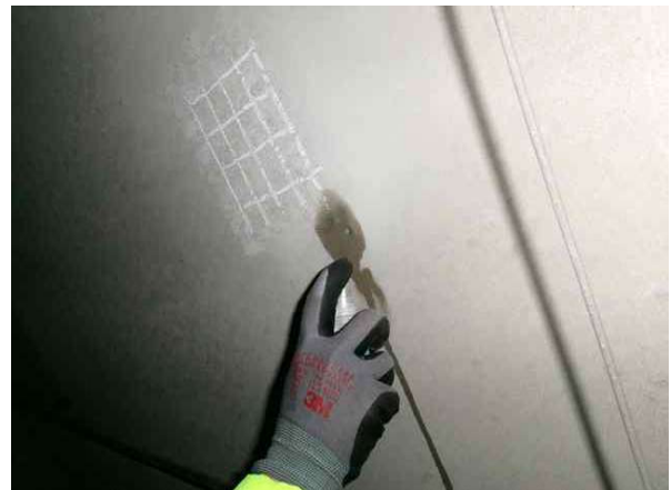
탄산화깊이 측정 현황
