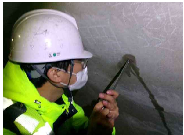
탄산화깊이 측정 현황
